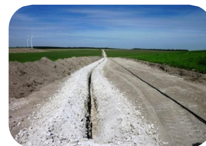
Réalisation des pistes et du câblage
