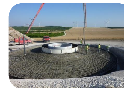
Coulage de la fondation
