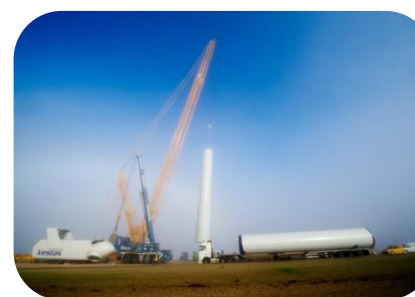
Livraison et Montage des tronçons de mâts
