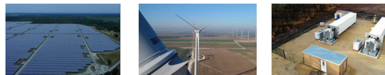
Figure 3 : de gauche à droite, Centrale Solaire de Cestas (300 MWc), Centrale Eolienne de Bussy-Létrée (26 MW), et Azur Stockage (6 MW, 6MWh) (source : NEOEN, 2019)
